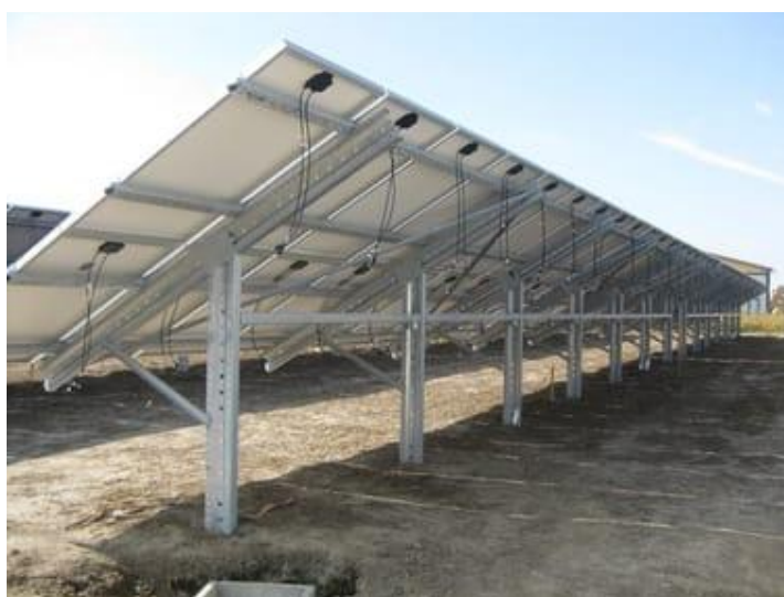
Figura 7. 10 - Particolare scatola di giunzione
