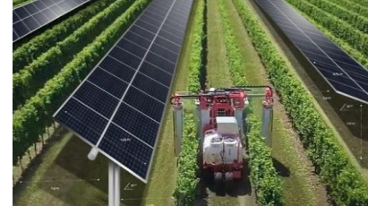
Figura 10 - Sistema agrivoltaico in cui la coltivazione avviene tra le file dei moduli fotovoltaici, e non al di sotto di essi (TIPO 2).
