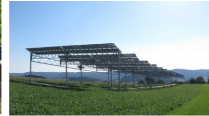
Figura 9 - Sistema agrivoltaico in cui la coltivazione avviene tra le file dei moduli fotovoltaici e sotto a essi (TIPO 1).
