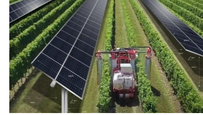
Figura 10 - Sistema agrivoltaico in cui la coltivazione avviene tra le file dei moduli fotovoltaici, e non al di sotto di essi (TIPO 2).
