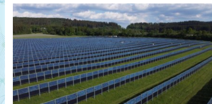
Figura 11 - Sistema agrivoltaico in cui i moduli fotovoltaici sono disposti verticalmente. La coltivazione avviene tra le file dei moduli fotovoltaici, l’altezza minima dei moduli da terra influenza il possibile passaggio di animali (TIPO 3).
