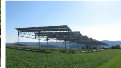
Figura 9 - Sistema agrivoltaico in cui la coltivazione avviene tra le file dei moduli fotovoltaici, e sotto a essi (TIPO 1).
