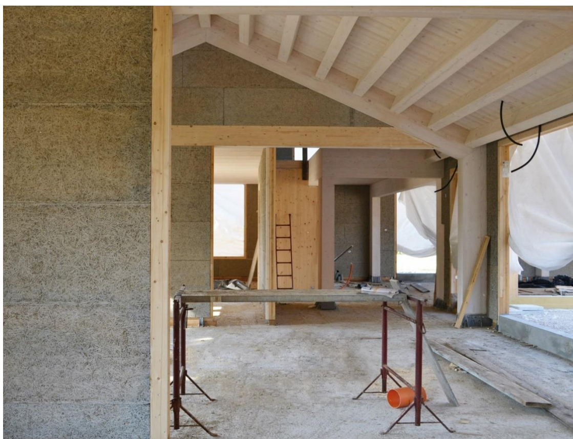
Figura 11 Esempio di un cantiere con soluzioni CELENIT per l'isolamento delle strutture d'involucro.
