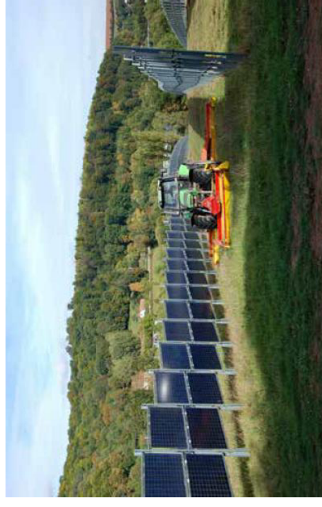
Impianti con moduli fotovoltaici bifacciali montati verticalmente su strutture fisse in the Eppelborn-Dirmingen solar park, Saarland, with 2 MWp capacity, constructed by Nex2Sun GmbH. © Nex2Sun GmbH
