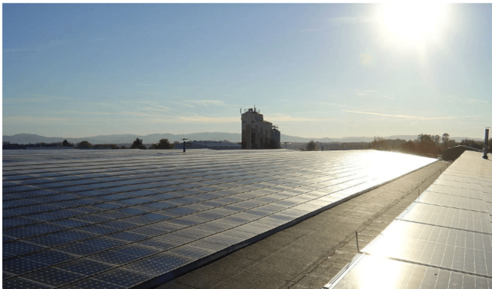
Figura 5 - Esempi tipici di abbagliamento causato da ampie superfici riflettenti (Fonte immagine sito https://www.pagerpower.com/news/glint-glare-definition , autore Micha Jost)
