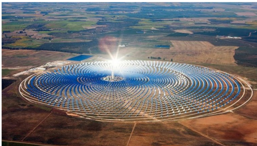
Figura 2 - Impianti a concentrazione solare
