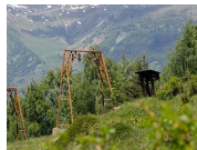
Impianti Loc. Breuil-Cima del Furggen
