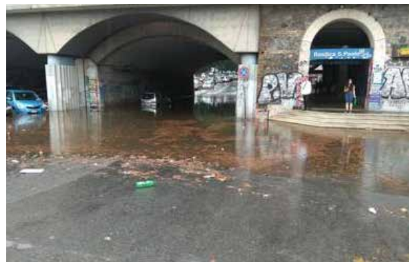
23 Luglio 2018 Allagamento metro Roma
