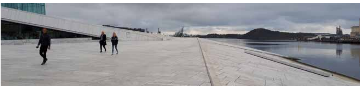
Oslo Opera House. Piazza studiata per adattarsi all'andamento del livello dell'acqua
