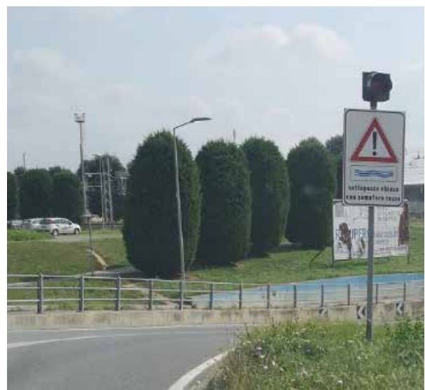
Semaforo anti allagamento a Carmagnola (TO)
