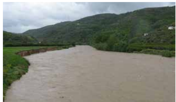
18 Gennaio 2013 Esondazione del fiume Crati che provoca l'inondazione degli scavi archeologici di Sibari (CS)
