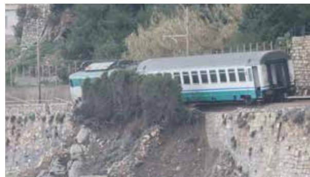
Gennaio 2014 Una frana provocata dalle piogge intense fa deragliare un treno Intercity in Liguria.
