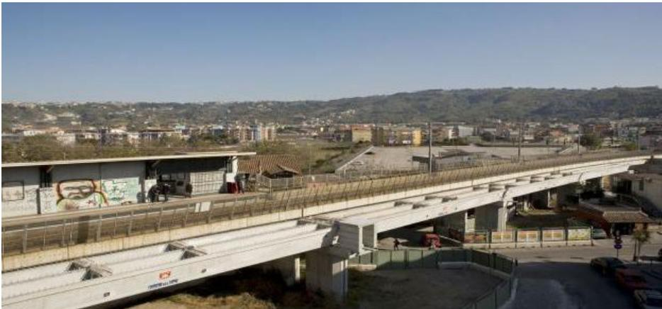
L'opera include 3 km di raddoppio ed il completamento del viadotto di Quarto, la realizzazione di due contigui ponti in corrispondenza del centro storico dell'abitato di Quarto ed il completamento delle opere civili della sede ferroviaria con opere di sostegno e di regimentazione delle acque meteoriche. L'importanza di questo intervento risiede nella capacità della linea che vedrà la frequenza dei treni dagli attuali 20 minuti passare a 10 minuti.
